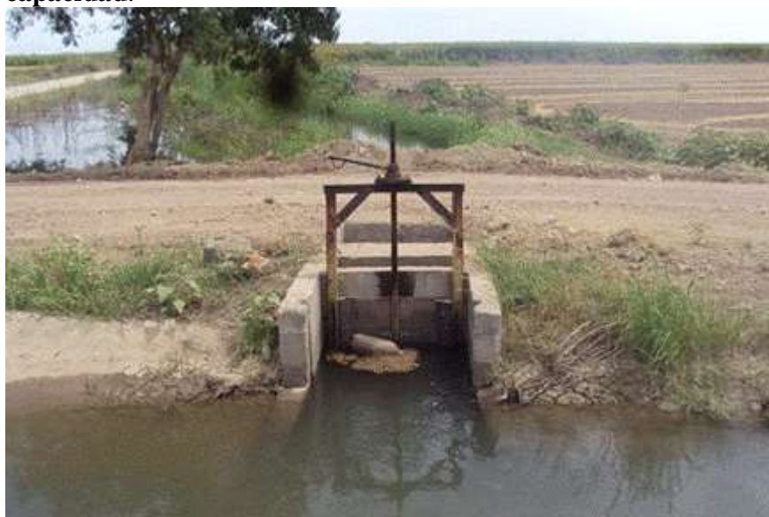
Figura 27. Foto de canal con desperdicios de agua por manejo de volúmenes superiores a la capacidad.
