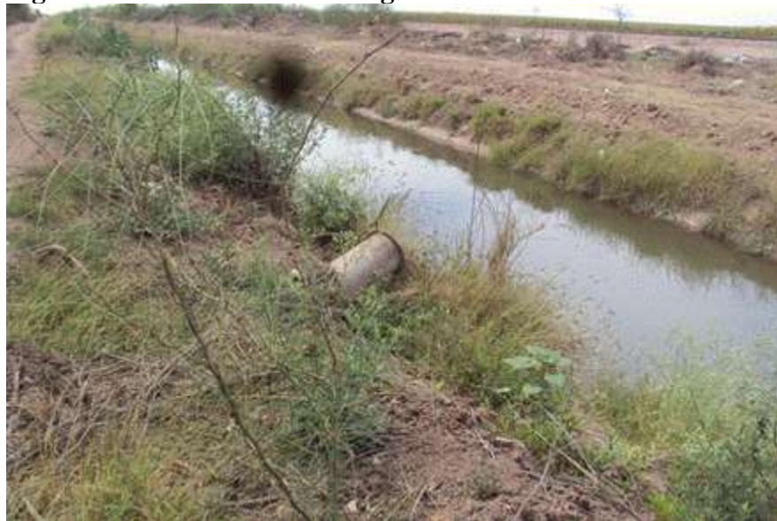
Figura 30. Foto de canal con vegetación dentro de la infraestructura.
